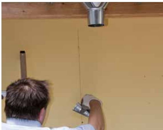
2 Alignement du réseau de descente et fixation du premier support (ici : clé de la bague autobloquante)
