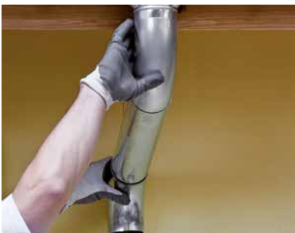
3 Préparation de la «bascule» ou du «col de cygne»
