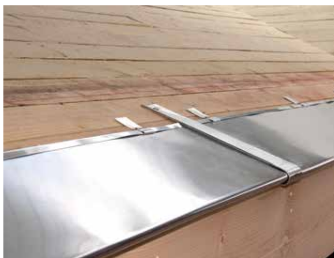
Jonction des doublis entre eux par coulisseaux plats.
